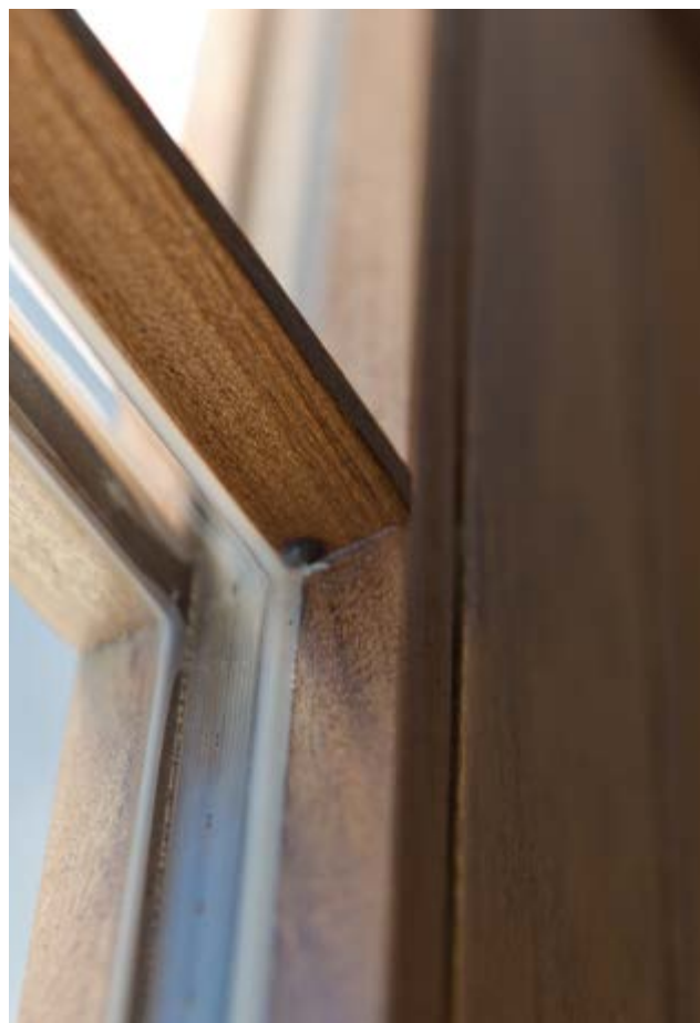
Finition discrète à l'aide d'un joint ► silicone
